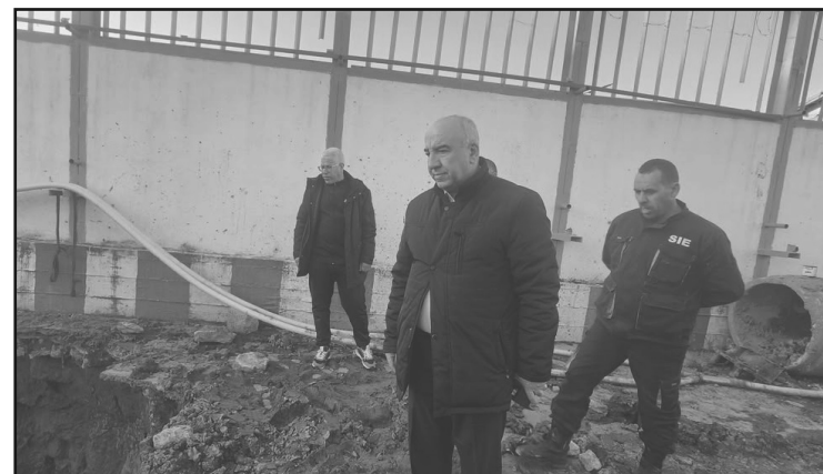
مع إعادة تهيئة الواجهة البحرية لشاطئ القصبة
